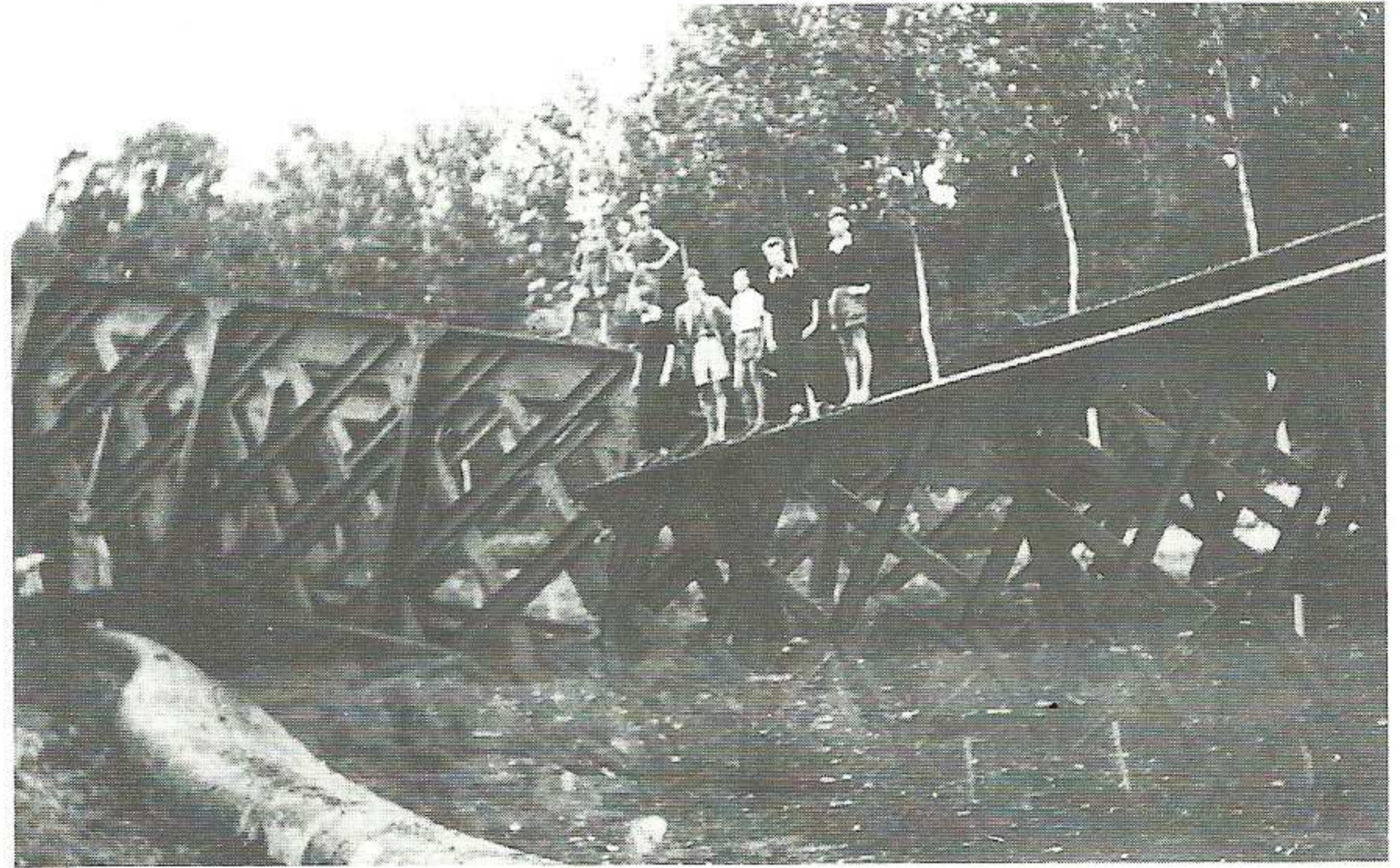
Le pont métallique détruit par les allemands en 1944
