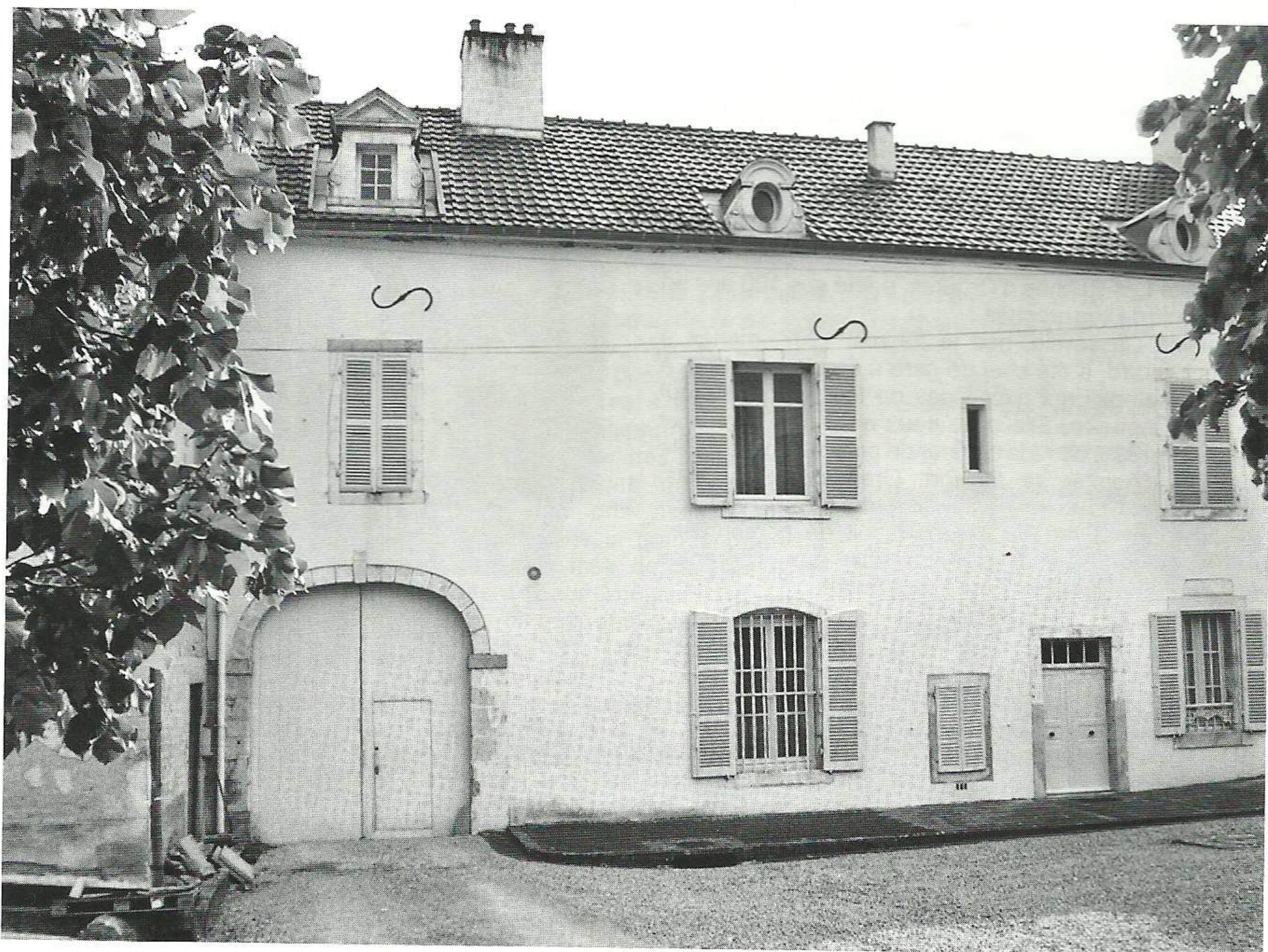
L'ancien relais. Façade vers la route
