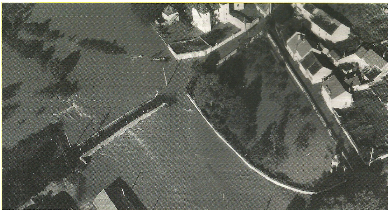
La crue du 1 er octobre 1965. Le flot submerge l'extrémité nord du pont et recouvre le Pasquier.
