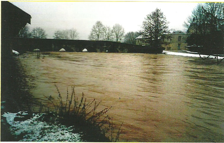
Le pont presque saturé par la crue de décembre 1993.
