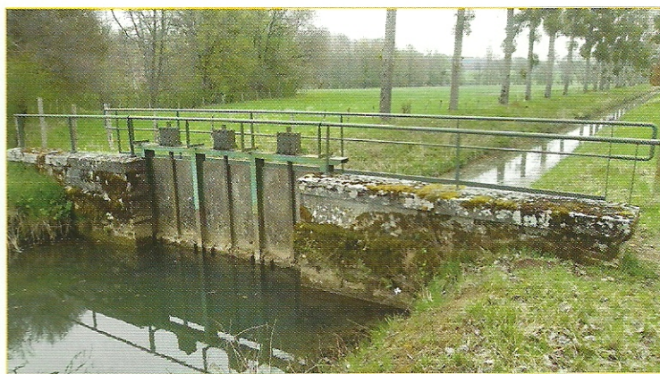
Prise d'eau de La Roche-Canot dans l'Ouche pour alimenter le canal
