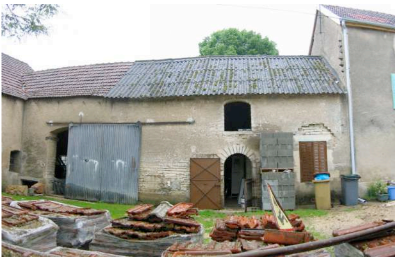
Bâtiment 3 – façade ouest
