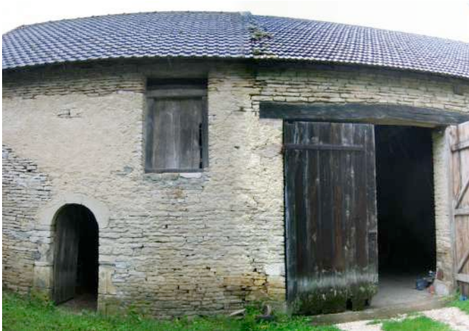
Bâtiment 1 – façade Est
