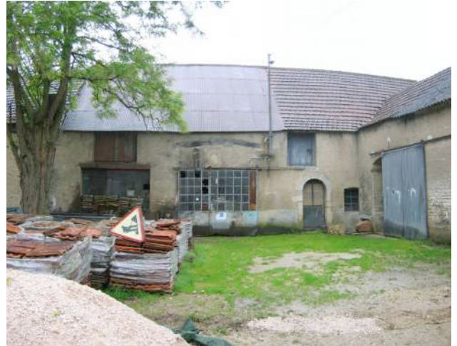
Bâtiment 2 – façade Est
