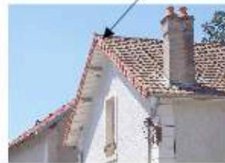
\* **La Dévirure** permet de renvoyer l'eau vers le centre de la toiture :
