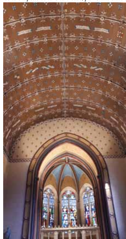
La chapelle de la Chartreuse restaurée, 2021
