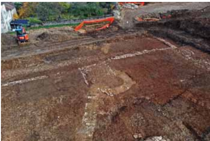
Tracé de la muraille et de la tour à l'emplacement du parking de la maison de santé. ©Com'Air
