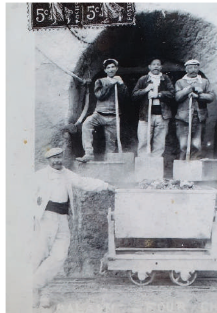
Un des fours de Mâlain (Candlot, 1903) : la chaux tombe dans des « recettes » situées de chaque côté du four puis, par des trappes, dans des wagonnets qui se placent en-dessous..
