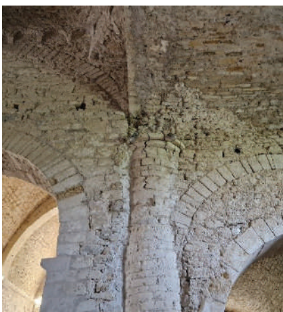
Remaniements anciens très visibles au niveau du transept
